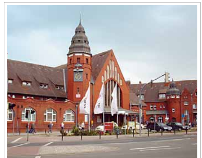
Das Dach der Empfangshalle des Bahnhofes wird ab Juli erneuert.
